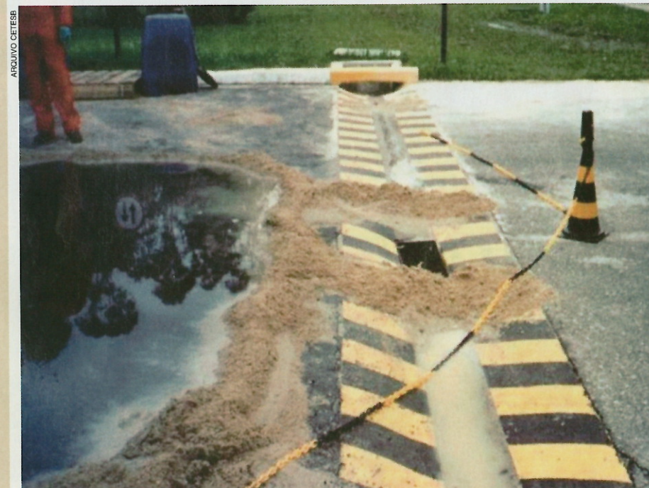
Dique de contenção para proteção de drenagem
